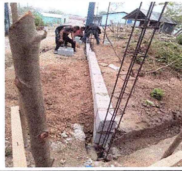
Foto 2: se sustituyo desde el cimientto del muro perimetral del programa de mantenimiento de edificios escolares
