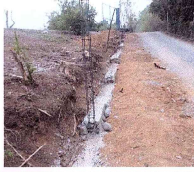
Foto 4: Se sustituyo cimientto del muro
